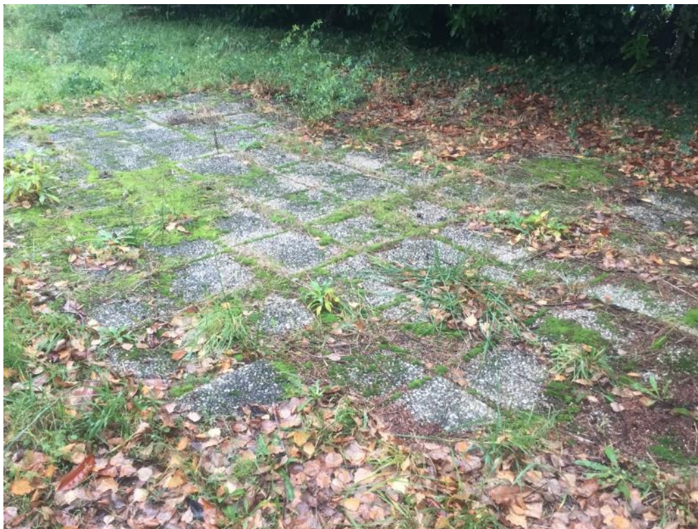
Figure 26 – Zone rudérale au sud du site, © ARP-Astrance 2021
