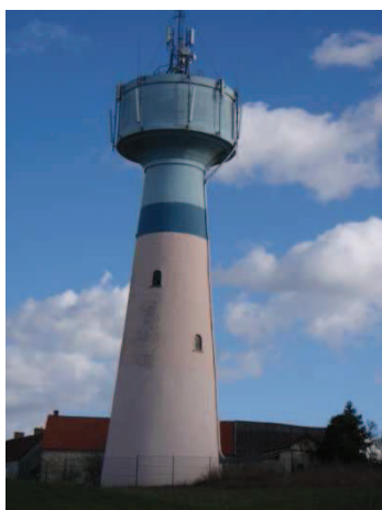
Château d'eau de Courdimanche
