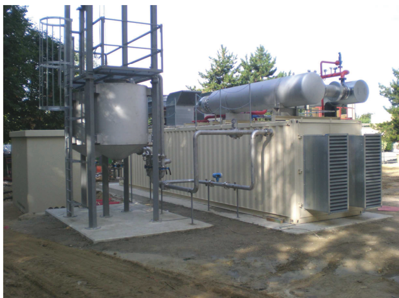
Système de co-génération et gazomètre
