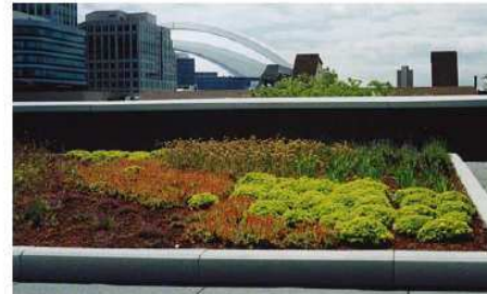
Toiture végétalisée Système extensif (type garrigue)
