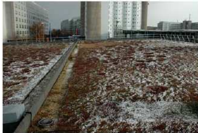
Toiture végétalisée avec tapis de Sedum Système extensif (type toundra) - Roissy
