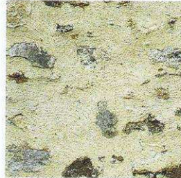
ENDUIT A PIERRES VUES
