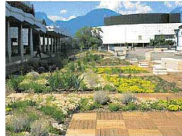
Terrasse végétalisée – Système semi-intensif Grenoble – Crédit agricole
